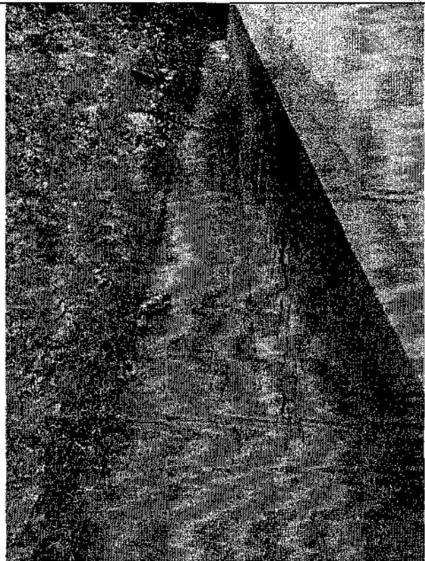
Фото 7, 8. Локальные участки трещин, следов растительности, проседания, неплотного примыкания отмостки к цоколю, отсутствие герметизации. Через образовавшиеся щели и отверстия происходит замачивание фундамента здания, а также подвального помещения, что не соответствует требованиям п. 6.26 СП 82.13330.2016 «Благоустройство территорий».
